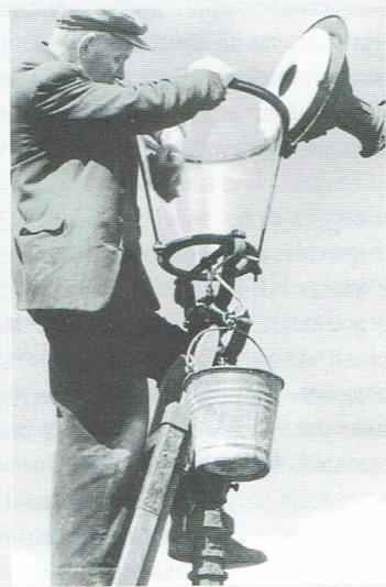
Prachtig beeld van een oude straatlantaarn, vermoedelijk een gaslantaarn, die hier een schoonmaakbeurt krijgt.
