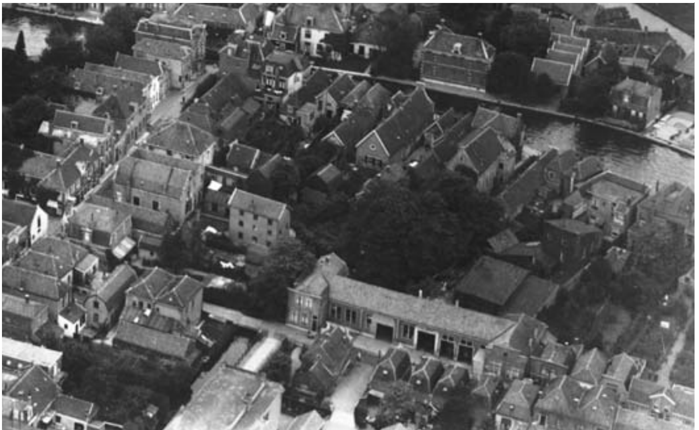
Detail van een luchtfoto die een deel van het centrum toont voor de komst van de hefbrug, die het centrum van Boskoop drastisch heeft gewijzigd. Op de voorgrond is de oude Nieuwstraat te zien met het toen al tot garage omgebouwde schoolgebouwtje. De foto geeft ook een goed beeld van de structuur die het centrum van Boskoop voortijds had.
